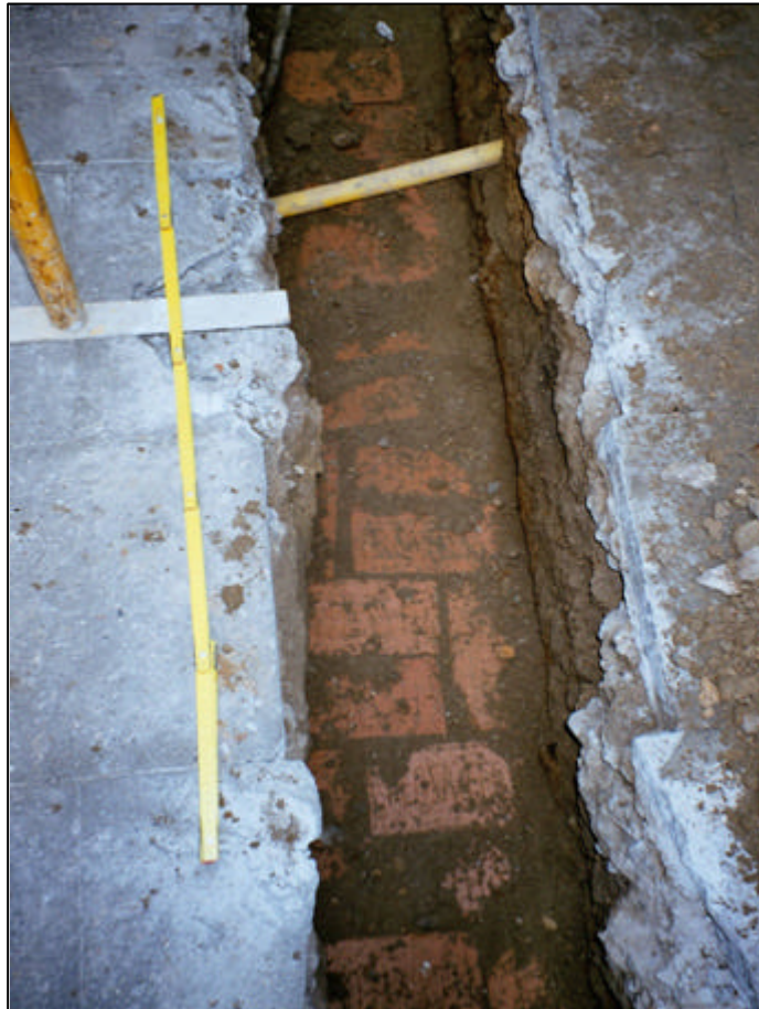
Fotografia núm. 3 Vista de l'aparició de serveis anteriors, en concret correspon a un altre servei de llum.
